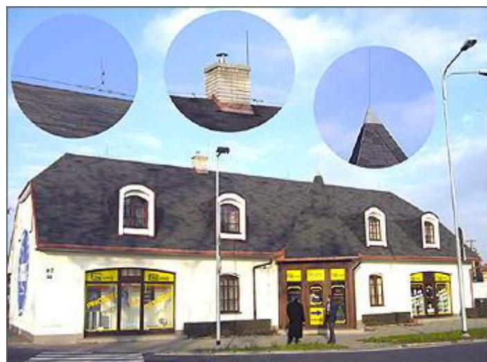
На приведенных фотографиях показан дом, система молниезащиты которого выполнена в виде так называемой молниеприемной сетки. Так как здание имеет усложненную архитектуру, помимо сетки на выступающих элементах конструкции крыши устанавливаются дополнительные штыревые вертикальные молниеприемники, которые должны обеспечить увеличение зоны защиты от прямого удара молнии. Существует
